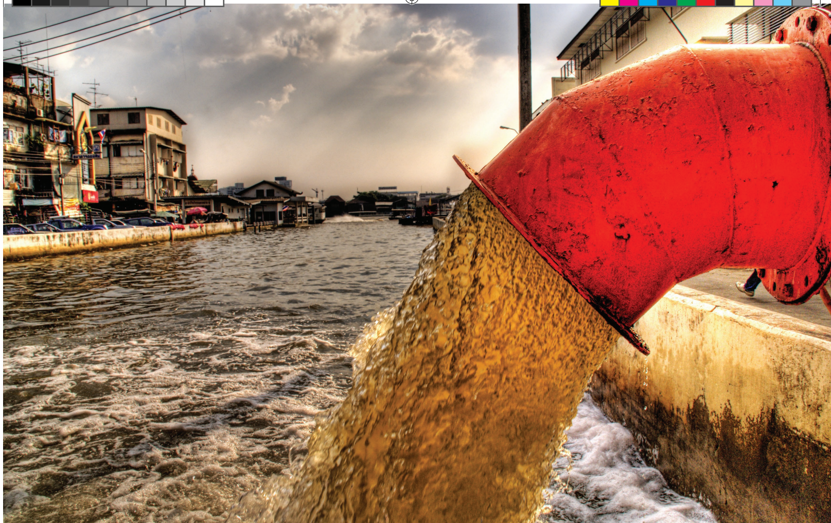
Канализационный сток. Фото/Trey Ratcliff Creative Commons
